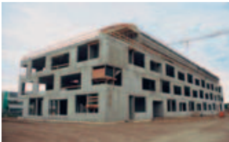
Rohbau von Südwesten. (Foto: Stephanie Schwarz, IBMT)
