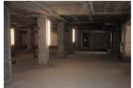
Vor dem Ausbau.
