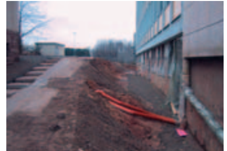
Sanierung der Fassade.
