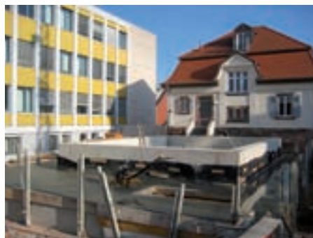
Weitere Impressionen des Baufortschritts.
