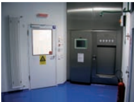
Abbildung 2: Zugang zum S3-Labor und Außenseite des Durchreicheautoklavs. (Foto: Frank Obergrießer, Fraunhofer IBMT).
