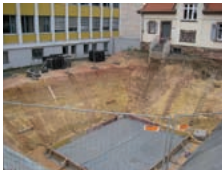
Betonboden für das Messbecken, eingelassen in die Sandsteinschichtlagen des Untergrunds.
