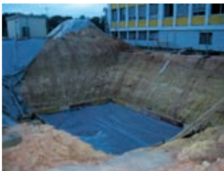
Erdaushub für das Ultraschall-Messbecken.
